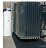
Eignet sich ideal zum Unterlegen undichter Transformatoren.
