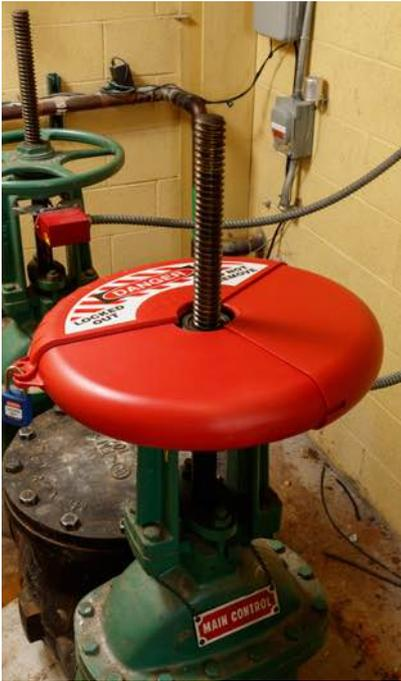
Brady bietet zusammenklappbare Vorrichtungen, die ein sicheres Absperrn verschiedenster Durchgangsventile ermöglichen, sodass weniger Vorrichtungen erforderlich sind. Diese Absperrvorrichtungen lassen sich ganz einfach an Ventilgriffen in der vollständig geschlossenen Position anbringen. Sie können aber auch zusammengeklappt werden, sodass sie auf Wartungswagen und in Lockout-Sets weniger Platz in Anspruch nehmen.
